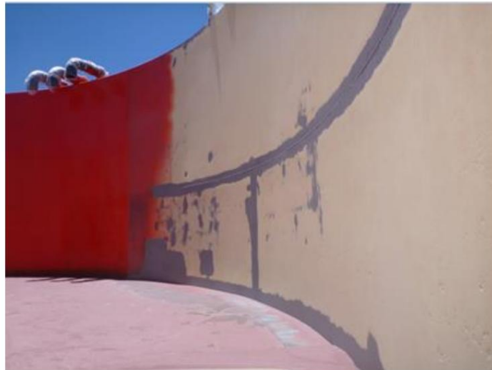
Chuẩn bị bề mặt trên thành bể
